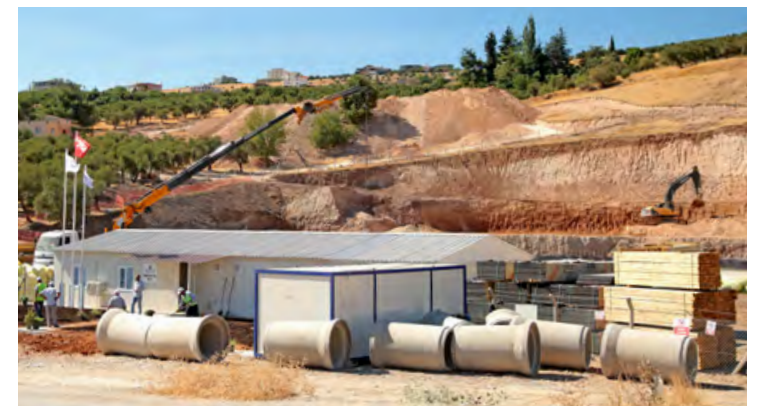
Kahramanmaraş Dulkadiroğlu Belediyesi Kamu Külliyesi Altyapı Çalışmaları
