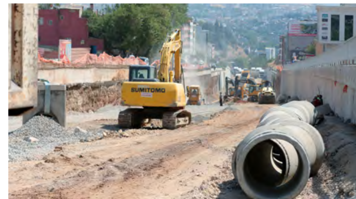
Kahramanmaraş Karamanlı Kavşağı Altyapı Çalışmaları
