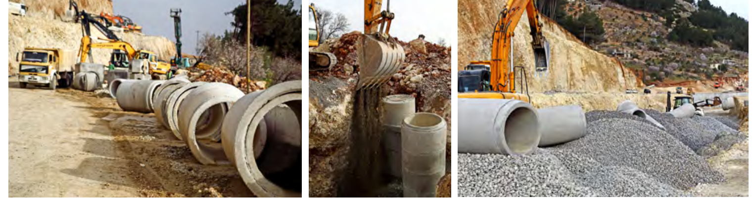
Kahramanmaraş Kuzey Çevre Yolu Altyapı Çalışmaları
