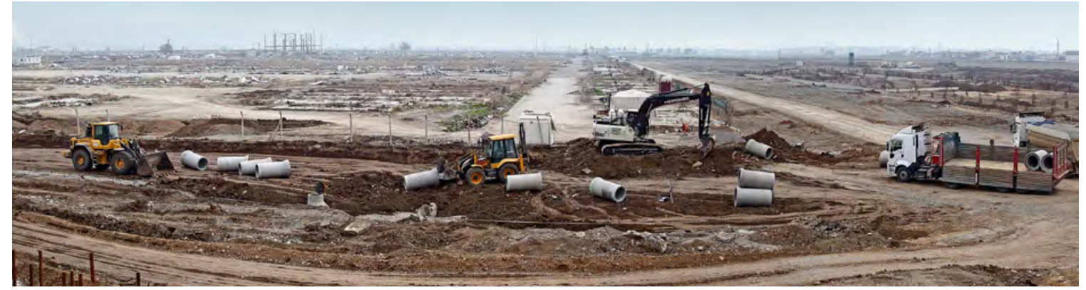
Kahramanmaraş Sanayi Sitesi Altyapı Çalışmaları
