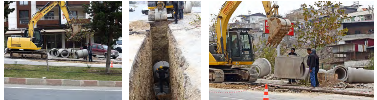
Kahramanmaraş Ağcalı Yokuşu Altyapı Çalışmaları
